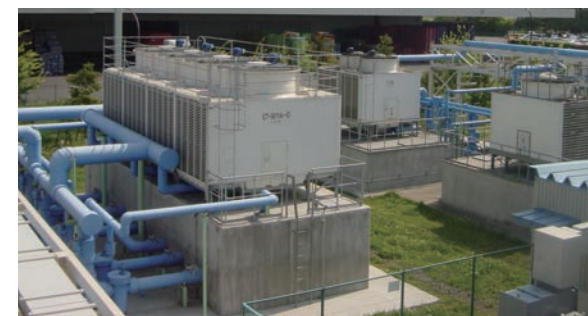
水循環設備 (板倉工場)
