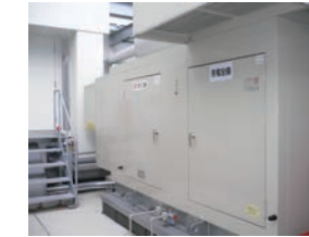
非常用発電機 (本社)
