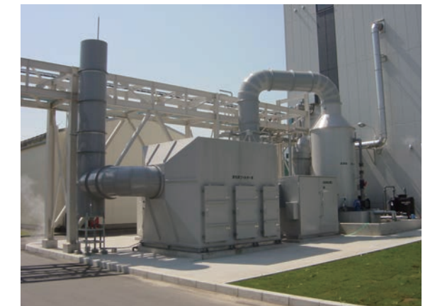
脱臭設備（板倉工場）
